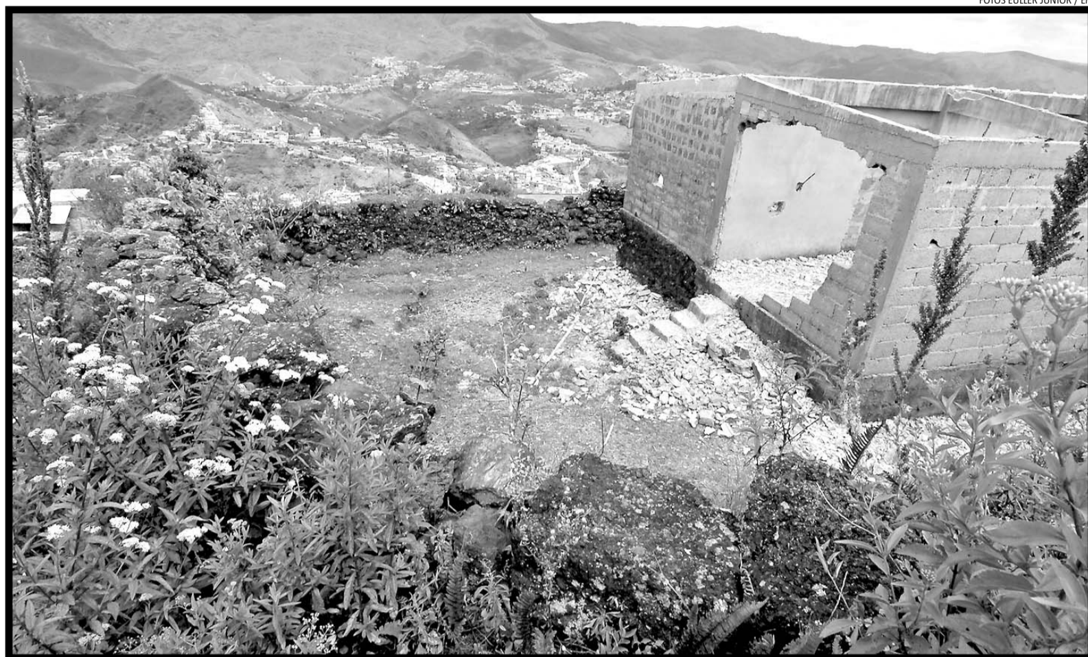
Programa da UFMG, Iphan e prefeitura incentivou a desocupação das famílias que fizeram construções irregulares no terreno e a demolição dos imóveis
