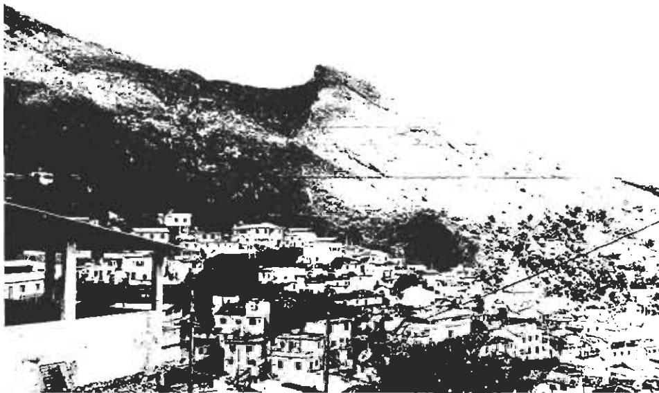
Fig. 5 - Alteração do relevo pelas antigas atividades de mineração no Bairro Veloso. Notar blocos rochosos em situação de instabilidade.
